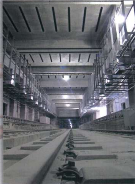
مترو شیراز - تقویت تیرها و دالهای سقف ایستگاه مترو با FRP برای افزایش ظرفیت باربری سقف
