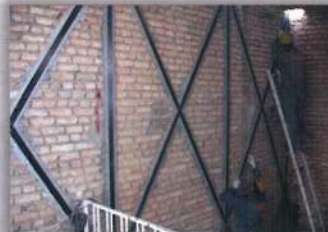
موزه دکتر شریعتی در تهران - بهسازی لوزه ای و تقویت ساختمان آجری با FRP با همکاری شرکتهای SMTTeam و EMPA (سوئیس)
