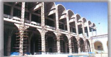
مصلی بزرگ تهران تقویت سازه های بتنی به روش Steel Jacketing
