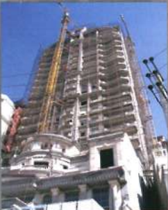
برج تندیس - تهران - نیواوران - تقویت موضعی تیرها و ستونهای بتنی با FRP به دلیل تغییر کاربری طبقات بالا
