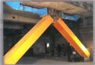
هتل بزرگ آزادی تهران کاربرد میراگرهای هیدرولیک (Viscous Dampers) برای جذب انرژی جانبی با همکاری شرکت FIP (ایتالیا)
